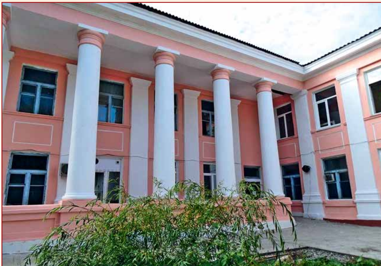
Городская больница после ремонта
