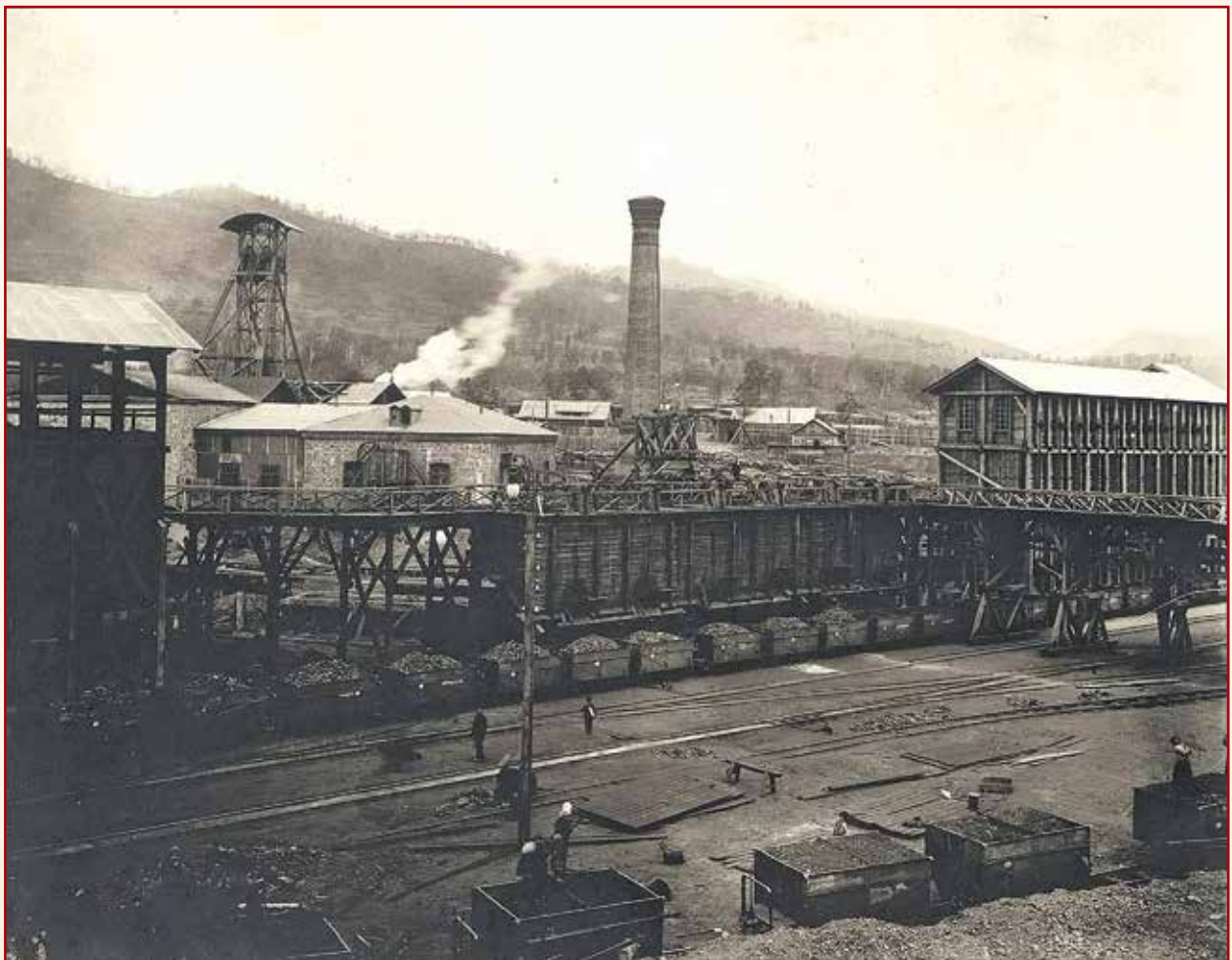
Наземные постройки шахты №2, 1912 г.
