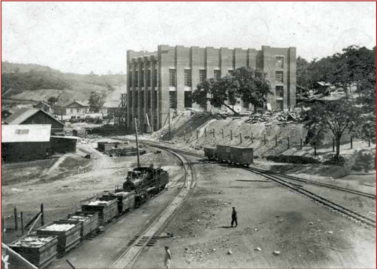
Строительство ЦЭС, 1931 г.
